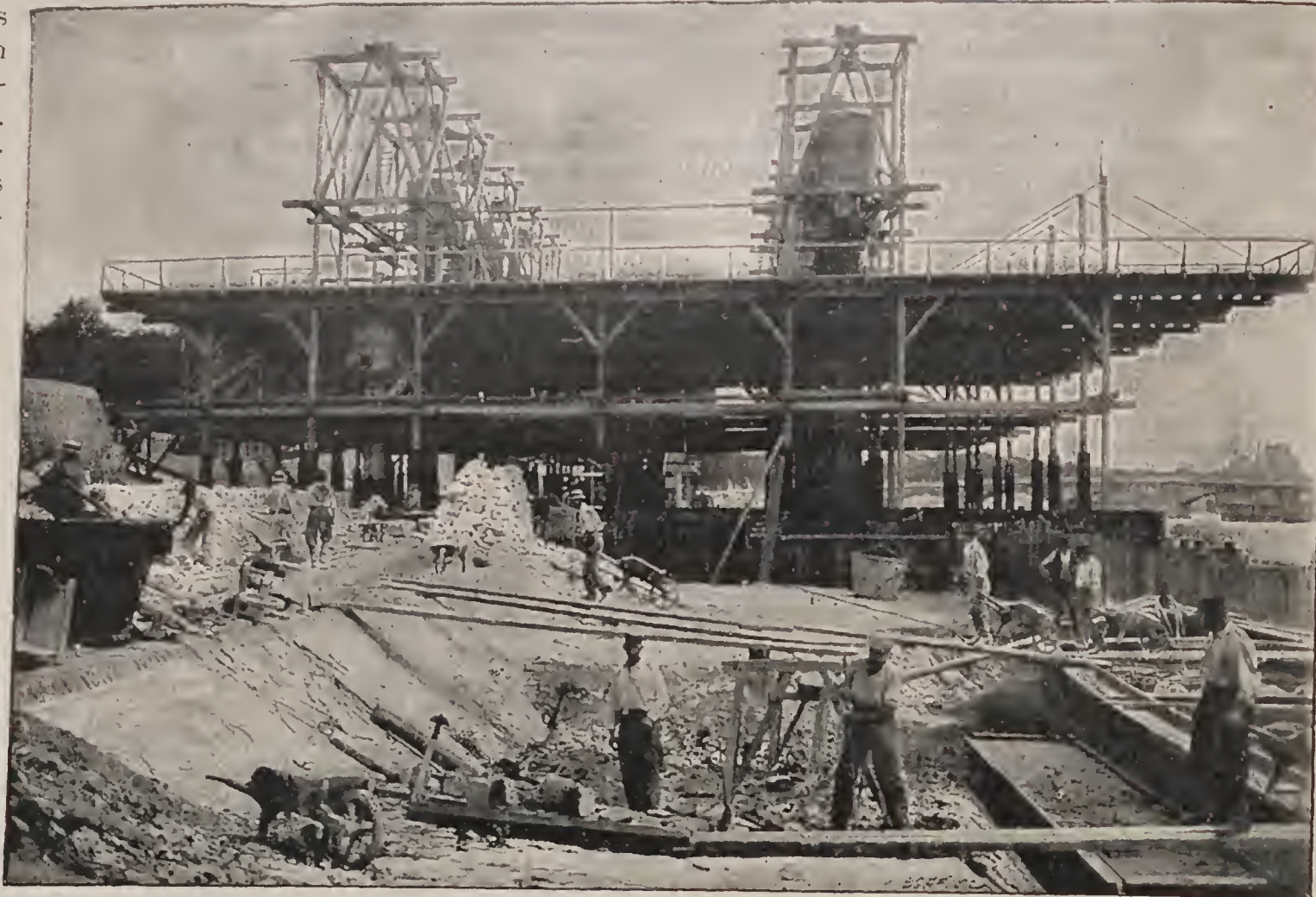
LE PONT ALEXANDRE III. — Le caisson de la rive droite.
